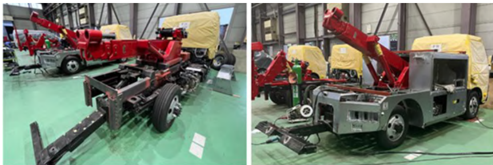
<図4-2-2 レッカー装置を架装中の状況>
